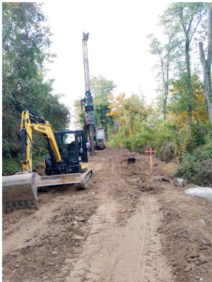
Sanacija plazov v Gradiščah.
