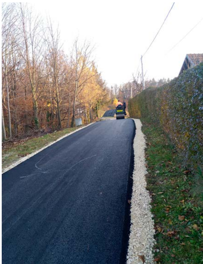
Asfaltiranje javne poti na Pohorju.
