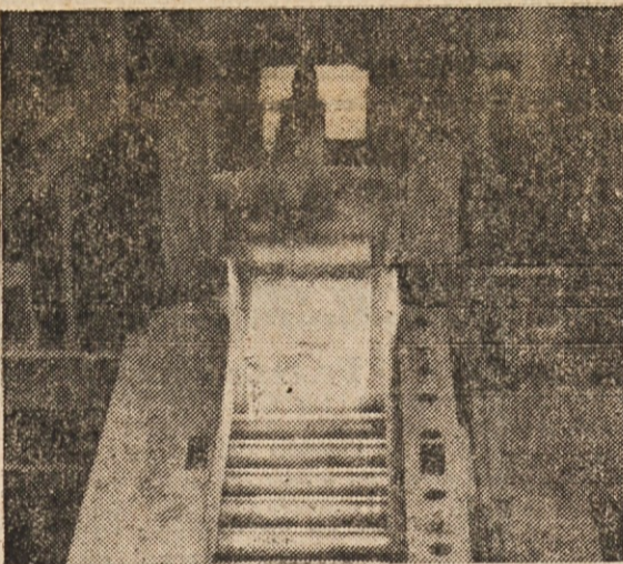
Vrteča se valjalnica stiska šibike jekla v plošče, palice ali pločevino pri temperaturah okoli 2100°F.
