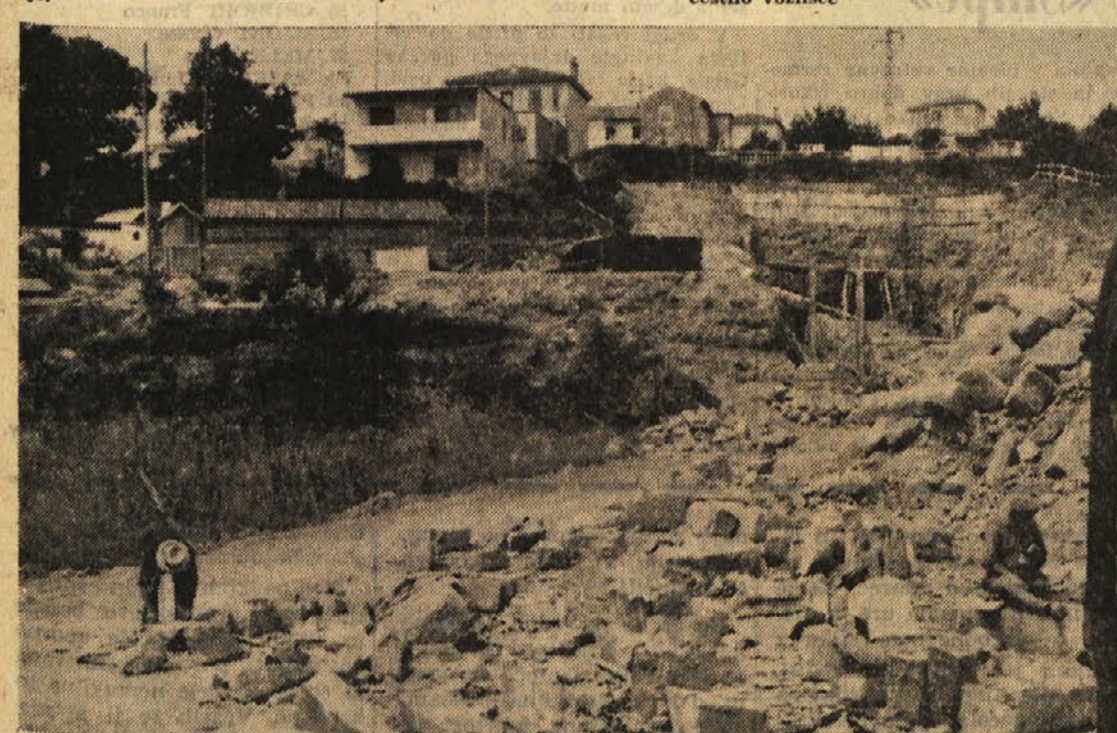
Te dni so začeli z delom za predor pod štramarjem (Zgoraj desno). Kamnoseki pripravljajo kamne za skarpo ob koncu predora
