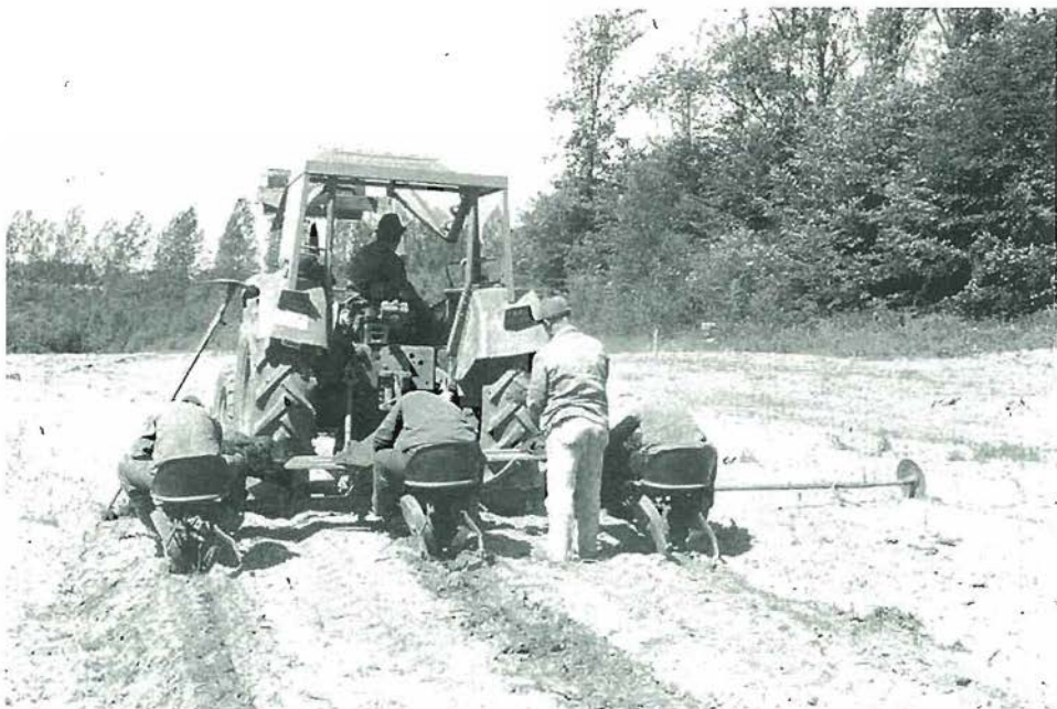
Sadnja hrastovih sadik s trivrstnim sadilnim strojem (Accord) na predhodno pripravljeni poseki. Foto M. Hočevar
