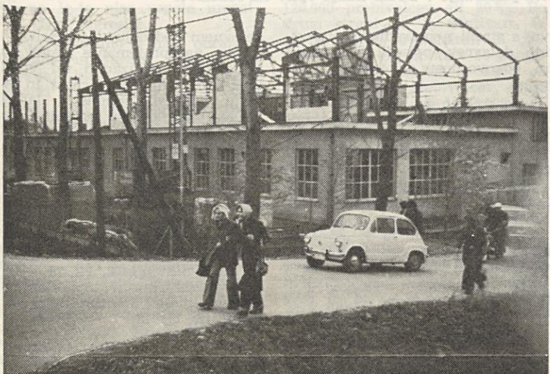
Nadgradnja poslovnih prostorov dobiva svojo obliko. Zgrajena je iz jeklene profilne konstrukcije in zapolnjena z lahkimi gradbenimi elementi. Strešna kritina pa bo iz aluminijske pločevine
