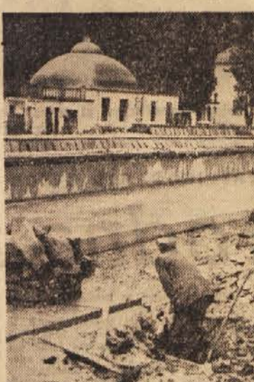
V Izlakah popravljajo kopališče, na prostem bodo uredili bazen
