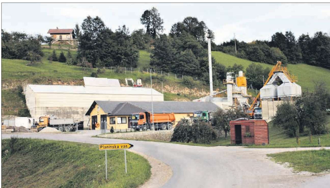
Asfaltna baza v Planinski vasi
