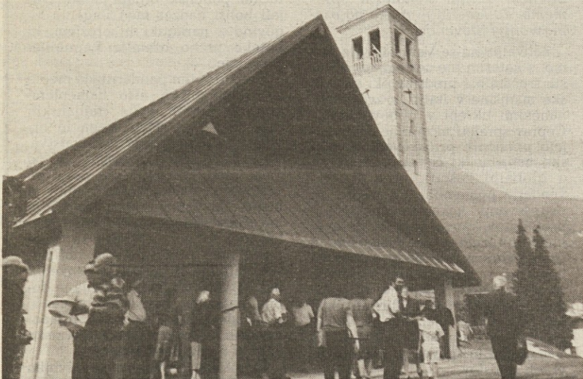
Pogled na zunanost nove cerkve v Bardu
