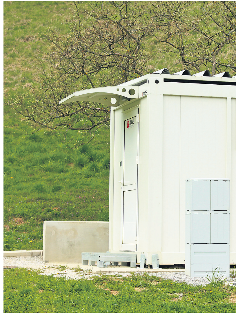
Na območju Majšperka in Žetal v dobrem letu dni zgrajenih 30 % priključkov
