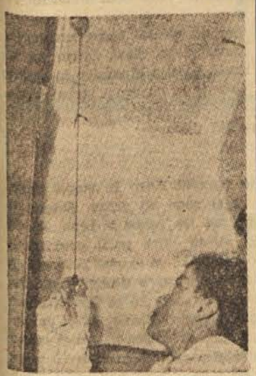
Varnostni ukrepi preprečujejo, da imamo v kopalnici ali pralnici električno koli električno stikalo. Silka kaže, kako z varico priigamo luč.
