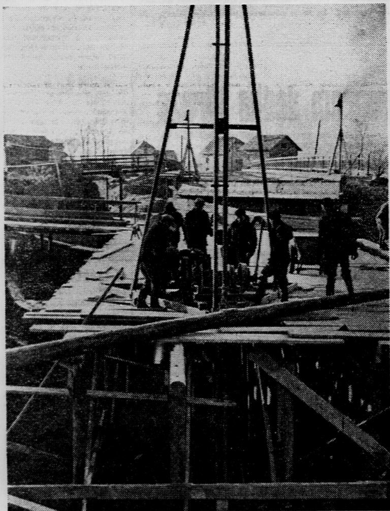
Na Izlanski cesti so pričeli z gradbenimi deli. Zaradi pogrezanja tal je bilo gradbeno podjetje »Slovenija ceste« primorano pešene podaljške mostu porušiti. Prišli so z gradnjo betonkega cestnišča, ki bo podaljšalo že izgrajeno cesto na mostu za 44 metrov na obe strani. Foto: J. Lamprecht
