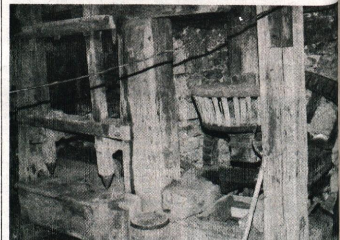
Notranjost mlina bo treba obnoviti; brata Železnik že snujeta načrte ideje.
