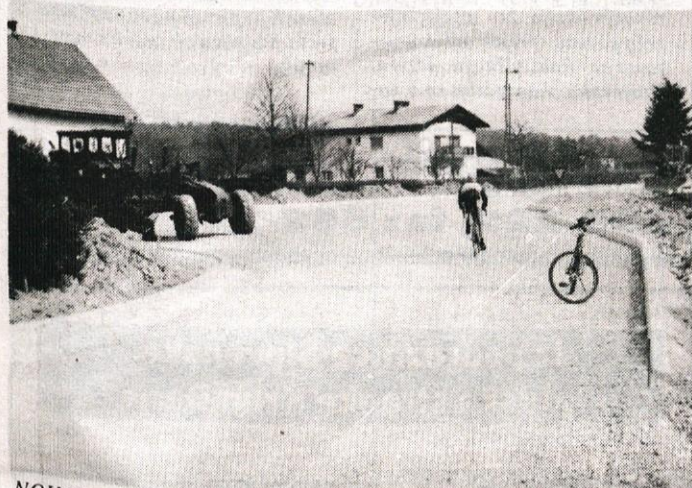
NOVO KRIŽIŠČE Z RONDOJEM — Potem ko so zgradili nov most čez Horjulščico in razširili cesto skozi Razorje, zdaj urejajo še cesto proti sami Dobrovi. Ob razpotju cest proti Polhovemu Gradcu oziroma proti Horjulu nastaja novo, sodobno križišče z rondojem, od mostu do križišča pa bo cesta dobila še pločnik. Na novo so uredili tudi komunalne vode, ki potekajo po tej cestni trasi. Gradbena dela opravlja Cestno podjetje Ljubljana. (bv)
