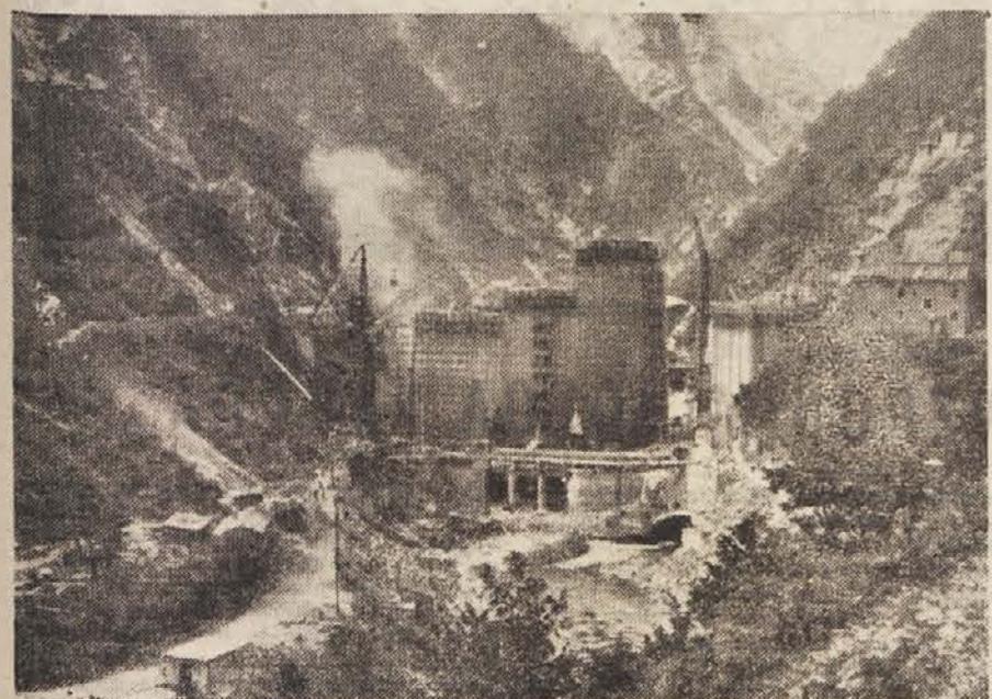
Zadnji posnetek z glavnega jezera hidrocentrale Jablanice, ki bo visok 80 metrov in čez katerega bo speljana nova cesta
