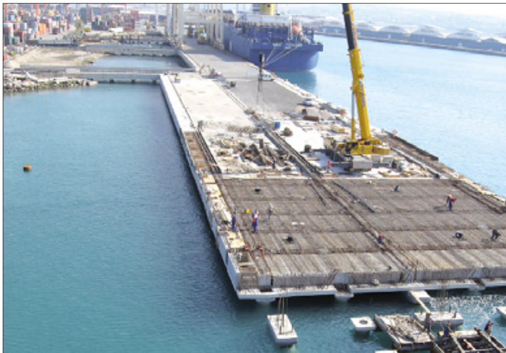
Pogled na pomol za kontejnerski promet, ki je v gradnji v luki Koper
