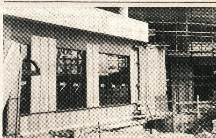
V Domžalah pospešeno gradnja Beton iz Zagorja in Ingrad iz Celja drugo fazo objekta SPB-1 in sicer del, ki so ga poimenovali LA-MELA - E.
