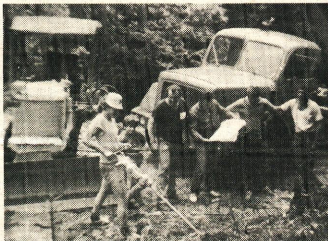
Strojna dela pri izkopu temeljev za RTV oddajnik na Limbarski gori
