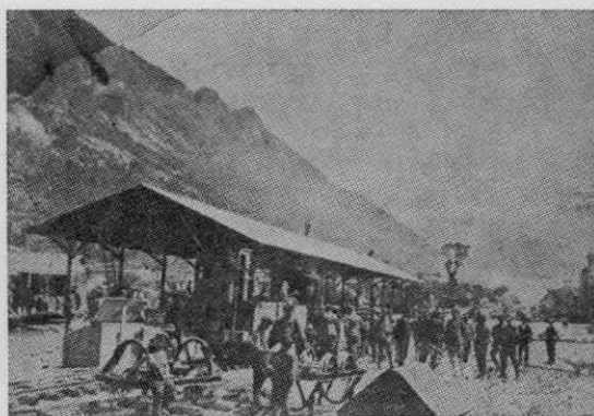
Proga Cedad—Kobarid — gradnja postaje Stupica (1915)
