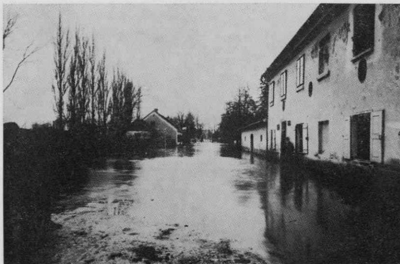
Poplavljena Ljubljanska cesta, na desni dom onemoglih — Marodenhaus. (Fotograf: Julija Martini)
