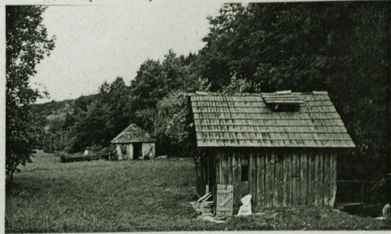
Ostanki Špančkovih stop in stavba hidroelektrarne iz 1937 v ozadju.
