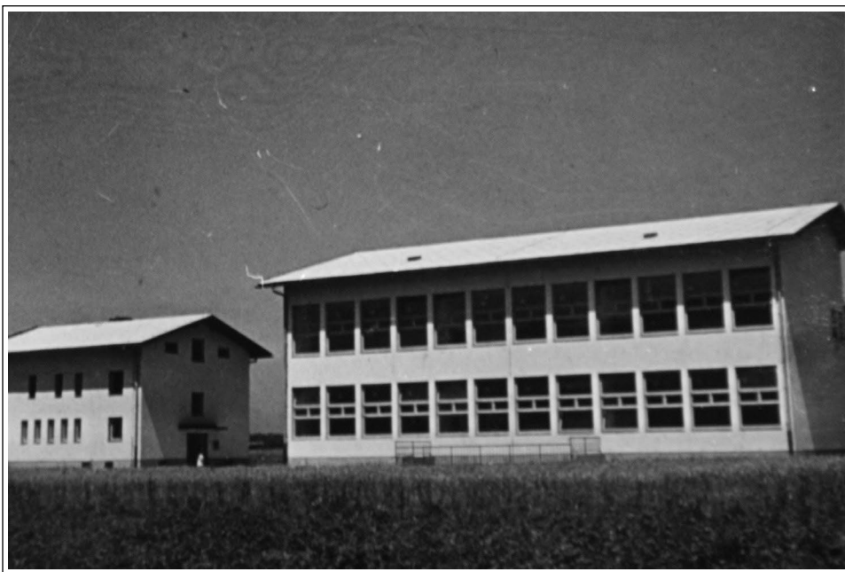
Novozgrajena Osnovna šola Simona Jenka Smlednik in učiteljski blok (Zbornik, str. 49)
