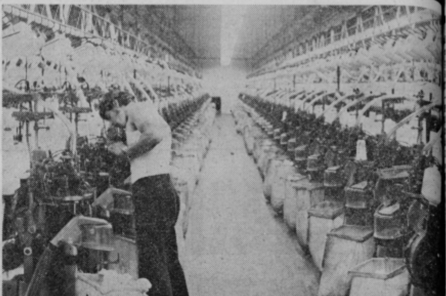
V pletilnici so v dolgih ravni vrstah razvrščeni pletilni stroji. Zadnji modeli so tehnike. En delavec streže kar 64 strojem. Male rdeče lučke z utripanjem opozarjajo, da se je iztekla nit, da je nekaj narobe. Preko 70.000 parov nogavic napletejo v enem
