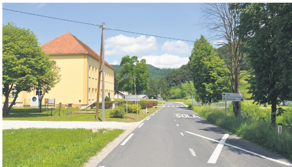
Zaradi nemotenega izvajanja gradbenih del pri izgradnji pločnika skozi naselje Stoperce je predvidena delna cestna zapora od 22. februarja do predbožičnega večera letos.
