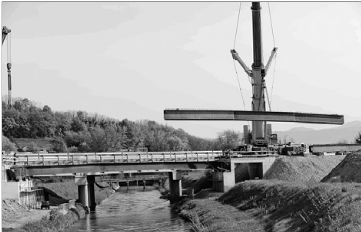
Med gradnjo mostu nad kanalom Agro pri Fari
