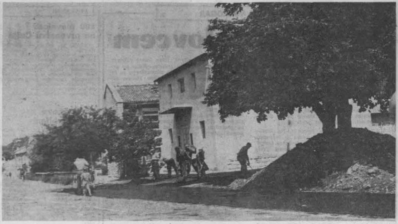
NIC VEČ PRAHU V DIVAČI — Delavci cestnega podjetja iz Kopra asfaltirajo vaške poti in dvorišča v Divači. Vsega skupaj bodo pokrpal 13 cest in tako v vasi ne bo več prahu oziroma blata. Asfalt bo stal 350.000 dinarjev. Stroške bo poravnala sama krajevna skupnost iz Divače. Dela, ki so se začela 11. junija, bodo predvidoma končana konec tega meseca. Na sliki: asfaltiranje ceste nasproti železniške postaje. Foto: A. Podbevšek
