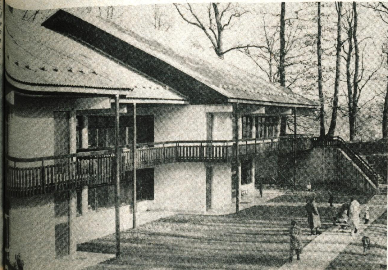
so zgradili nov vrtec, v katerem je tudi edini razvojni oddelek v radovljški občini.
