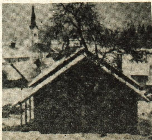
Na Bukovici gradijo prostore za telefonsko centralo.
