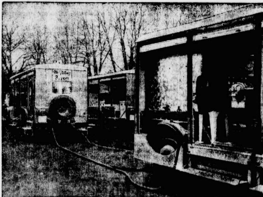
Der Maschinenwagen, der mit elektrischem Anschlusslabel mit dem anderen Wagen verbunden wird und so den ganzen Zug mit Strom versorgt.
