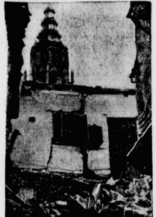
Die Sprengung des Alcazar in Toledo hat in der ganzen Stadt riesige Vermüstungen angerichtet. Hier sieht man einen Durchblick durch Häuferruinen. Auch die herrliche Kathedrale von Toledo, deren Turmspitze im Hintergrund aufragt, ist durch die Erschütterungen vom Einsturz bedroht. (Scherl-M.)
