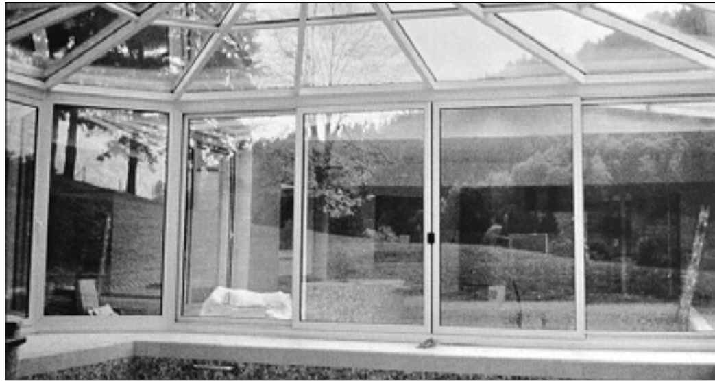
Zastekleni bazen na domu Bojana Križaja s pogledom na obsežni vrt, delo podjetja Savi
