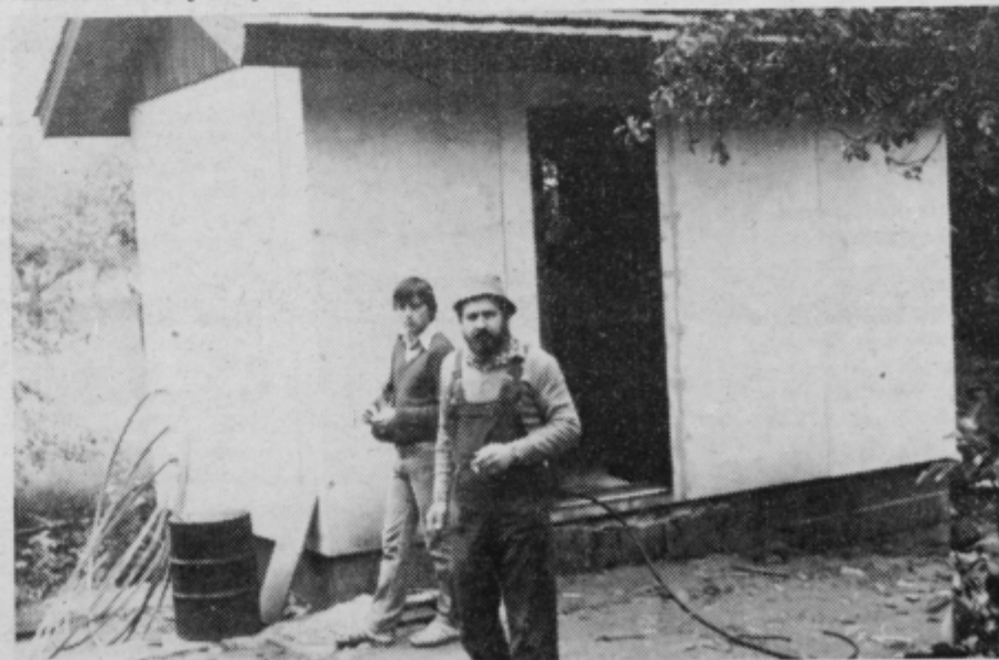
Pod streho majhne hišice je čistilna naprava. Pod njo je 2-metrski betonski bazen, zaščiten s posebno plastično prevleko. V bazenu so mešala in sonde za kontrolo kemičnih vrednosti. Vse to je elektronsko povezano. Tako elektronika skrbi za čiščenje odpadne vode in njena vrednost pri izpustu je v dovoljenih mejah čistoče.
